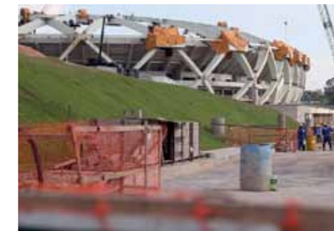
Ein Weißer Elefant am Amazonas? Die Arena Amazônia in Manaus während der Bauphase.
