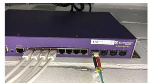
Abbildung 4: Ethernet Switch zum Anschließen der WLAN Access-Points
