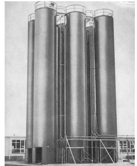
(7) Silogruppe aus Stahl zur Speicherung von Kunststoffgranulaten.
