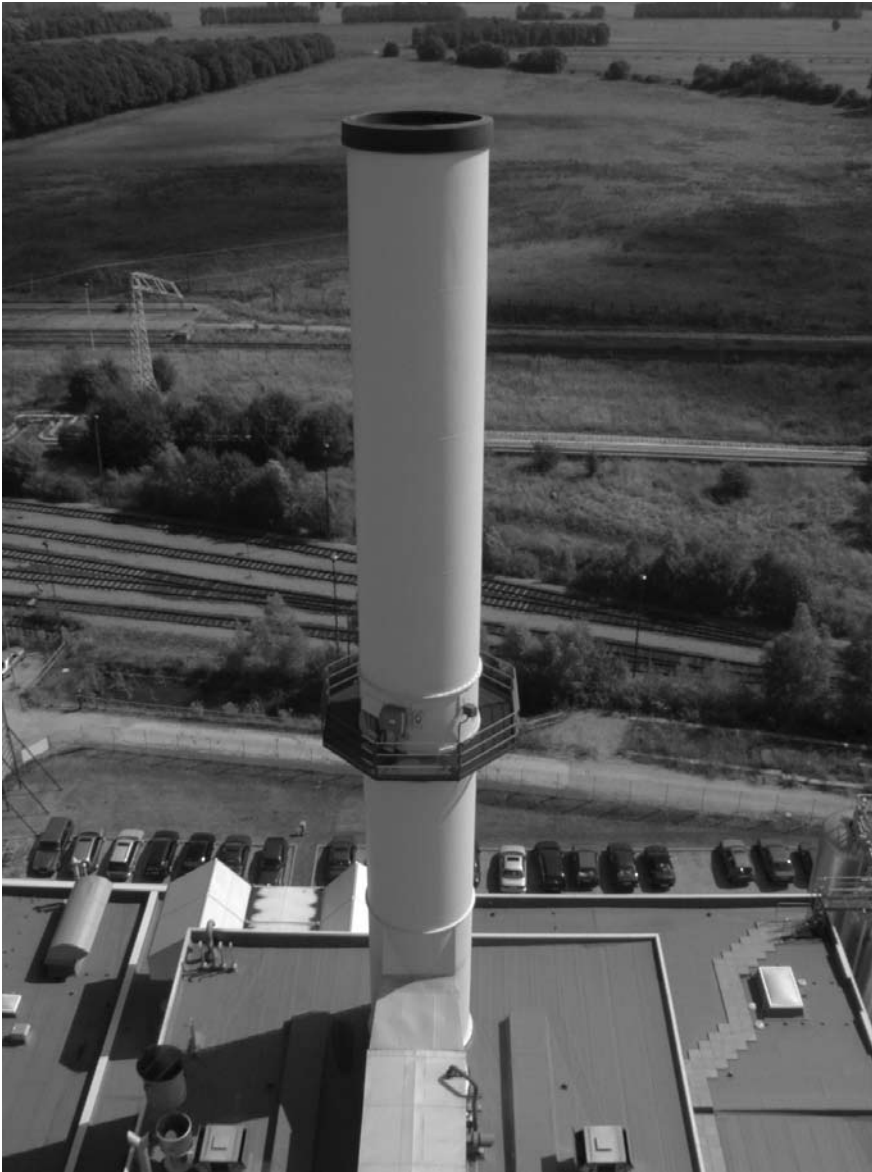
(10) Doppelmantelschornstein eines Heizkraftwerkes.
