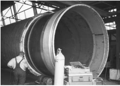
(12) Sanierung eines beulgeschädigten Edelstahl-Innenrohres mit Hilfe von eingeschweißten Wellenkompensatoren.
