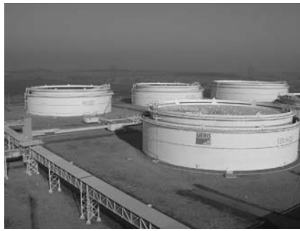
(15) Tankbehälter zur Zwischenlagerung von Rohöl.
