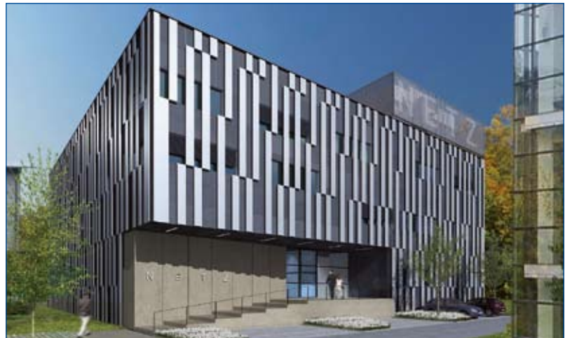
Für mehr als 43 Millionen Euro soll das neue NanoEnergieTechnikZentrum NETZ entstehen. Der Bau soll bereits im kommenden Frühjahr beginnen.
