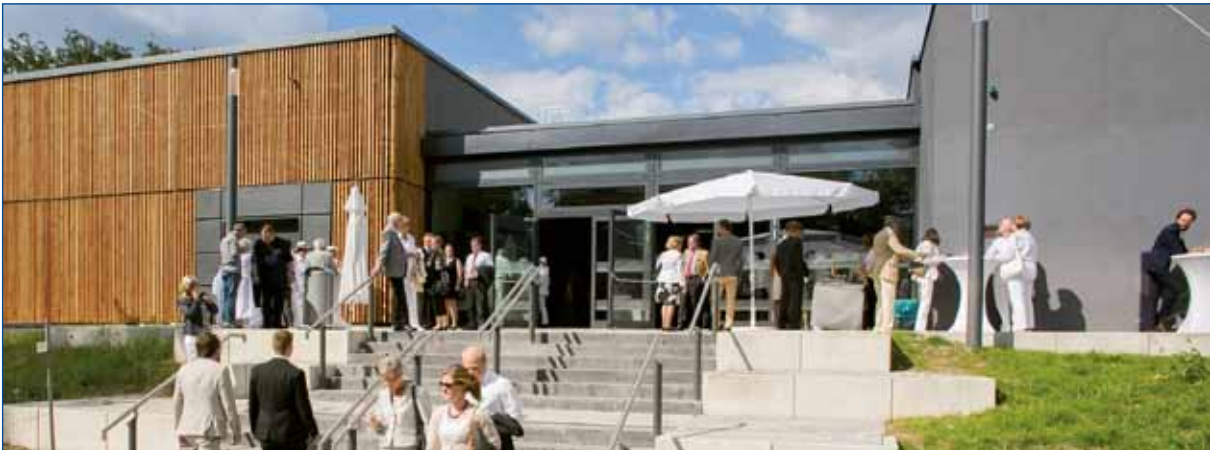
Glas und Holz in einem harmonisch in das Gelände integrierten Baukörper: Das neue Hörsaalzentrum bietet Platz für gut 1.000 Studierende.
