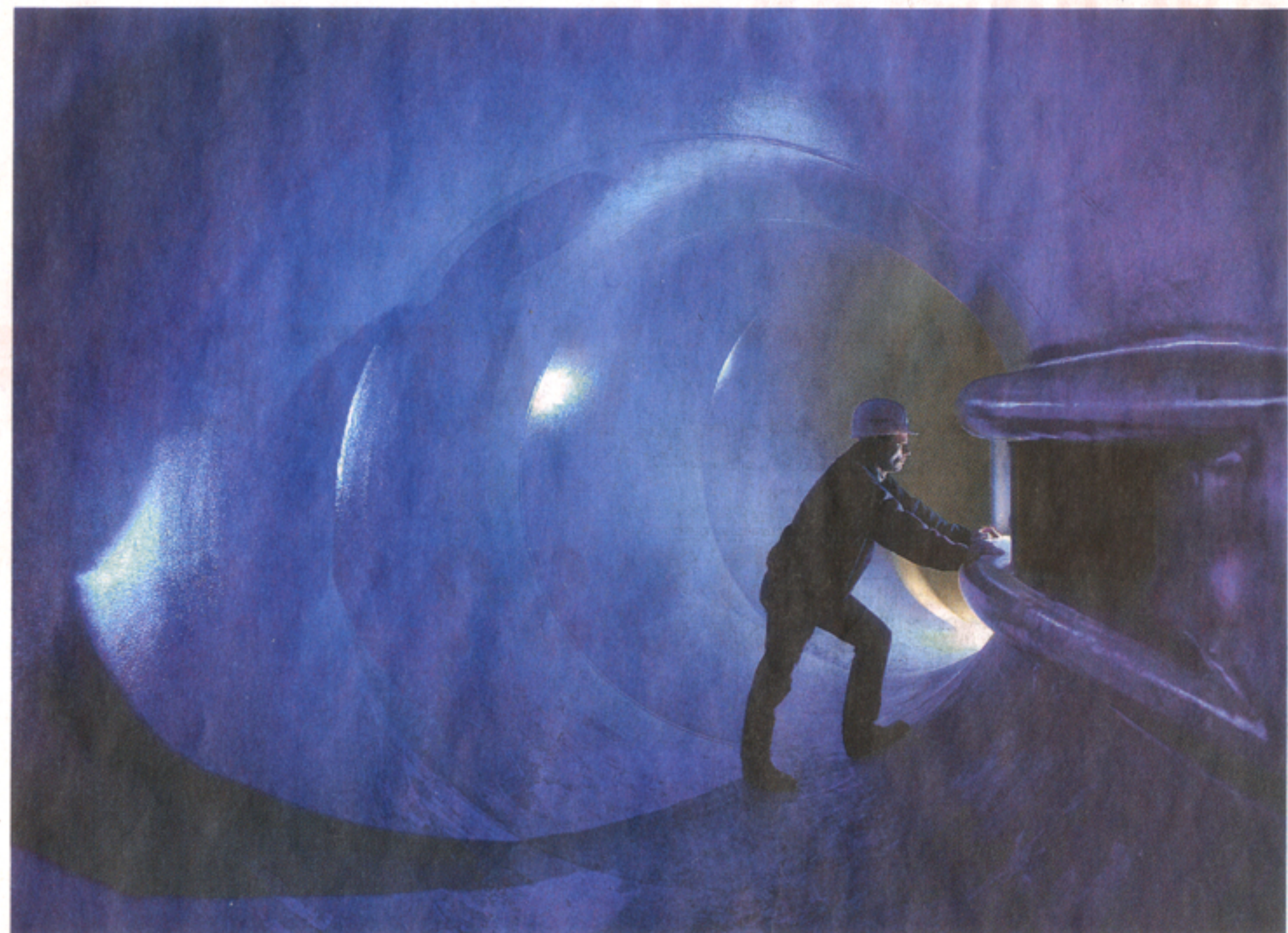
Überprüfung einer Turbinenspirale durch einen Mitarbeiter von Voith
